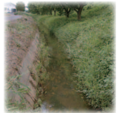
コンクリート水路でも傾斜があると生き物は出入りが容易にできます
